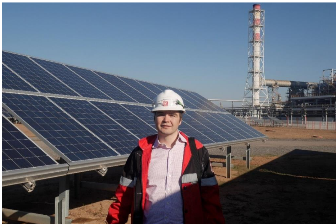
Рис. 2. Солнечная электростанция на Волгоградском НПЗ
